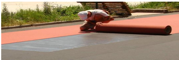
Obr. 4: Na připravené lepidlo rozviňte horní vrstvu
