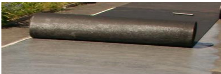
Obr. 2: Do připraveného lepidla rozviňte roli
