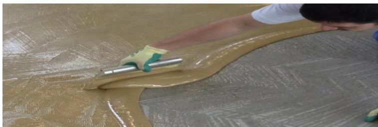
Obr. 1: Naneste lepidlo na suchý a čistý podklad
