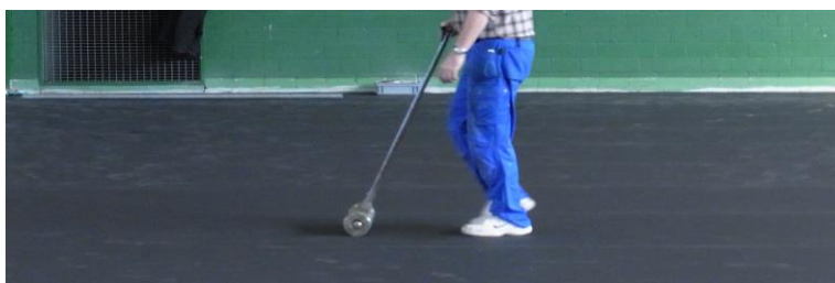
Obr. 3: Vrstvu SPORTEC® přitlačte válcem
